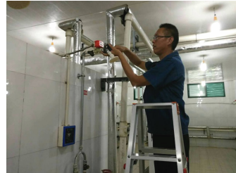
△ 浴室电动阀维修
