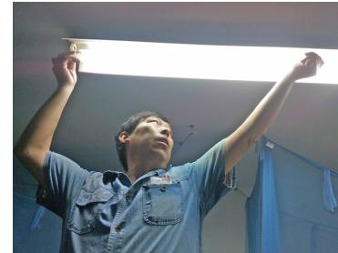
灯，周师傅先轻轻地敲了几下门，问道：“请问，有人吗？”，询问几次后见里面无人应答，便打开门，小心的架好入字梯，攀上顶端，仰起头仔仔细细地察看起来，从灯管、灯脚到线路，不放过一个细节。周师傅找出故障原因，重新换上新的灯脚，装上灯管，闪亮瞬间，满屋子的光明，在风雨里令人倍觉温暖。
